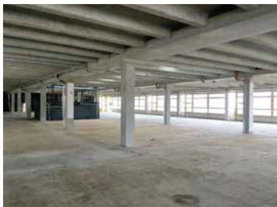
Blick in den ersten Bauabschnitt nach erfolgreicher Schadstoffbeseitigung und Entkernung
