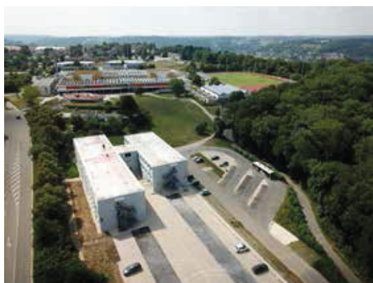
Blick auf die Gebäudemodulanlage als Ausweichquartier während der Generalsanierung
