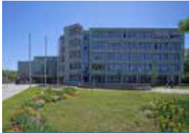
Hauptgebäude Stuttgarter Straße 41
